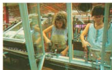
ケースメント窓の組立。
